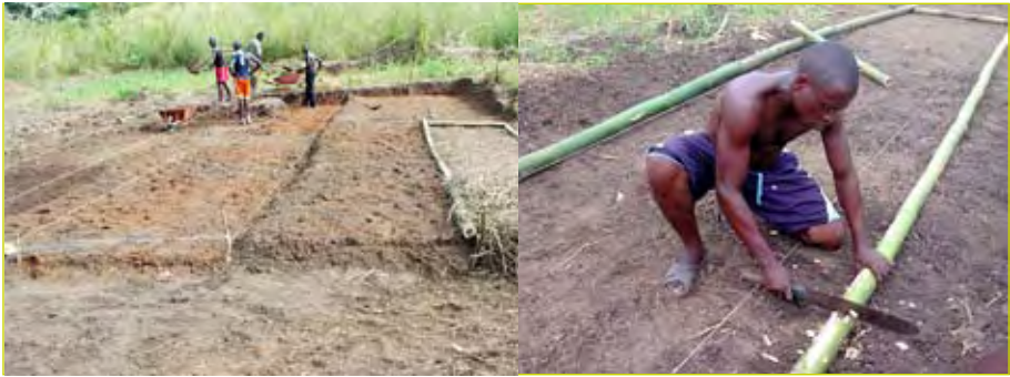
Piquetage de l'emplacement des bacs et coupe de bambous de 14 m et 1,5 m de long pour la mise en place de 4 bacs contigus de 1 000 acacias, J. Scholle, Gret, RDC, 2014.
