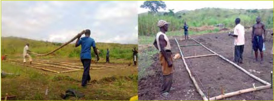
Installation des bambous et maintien au sol avec des piquets, J. Scholle, Gret, RDC, 2014.
