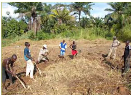
Début des travaux d'aplanissement après délimitation du terrain, J. Scholle, Gret, RDC, 2014
