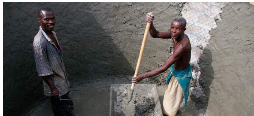
Construction d'une citerne, RD Congo
