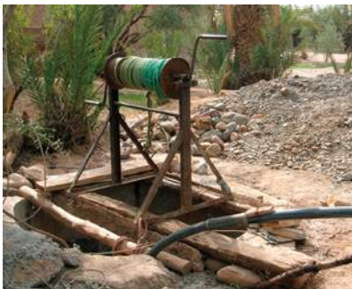
Construction d'un puits, Maroc
