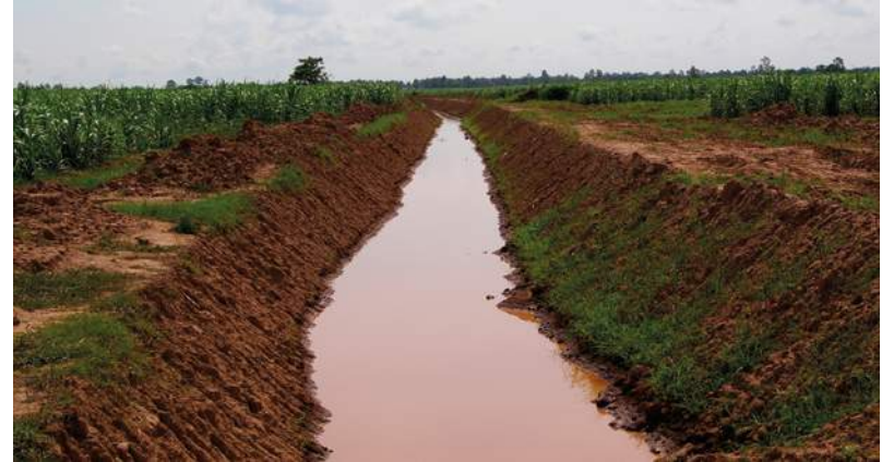
Canal d'amenée d'eau en cours d'aménagement, Cambodge
