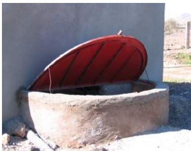
Protection d'un puits, Maroc
