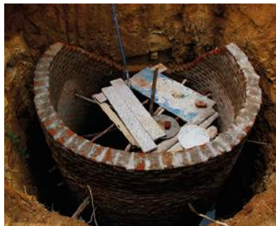
Construction d'un puits, Sri Lanka
