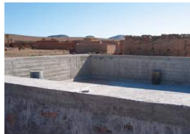
Bassin de stockage, Maroc
