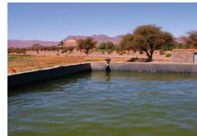
Bassin de stockage, Maroc
