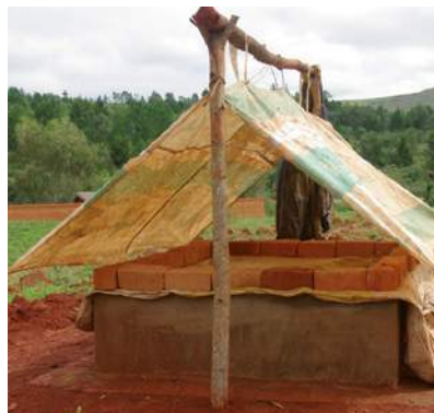
fosse à biofertilisant liquide maçonnée, Madagascar
