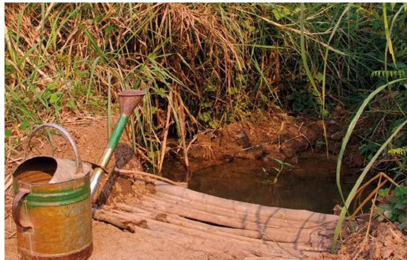
Point de captage aménagé, RD Congo
